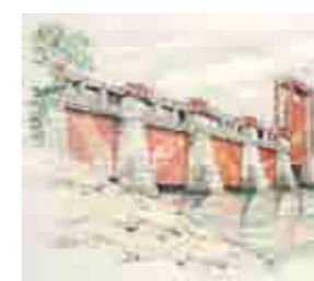
旧岩淵水門（北区）
