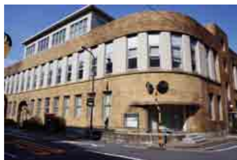
昭和4年の建築、千住郵便局電話事務所 現NTT千住ビル
